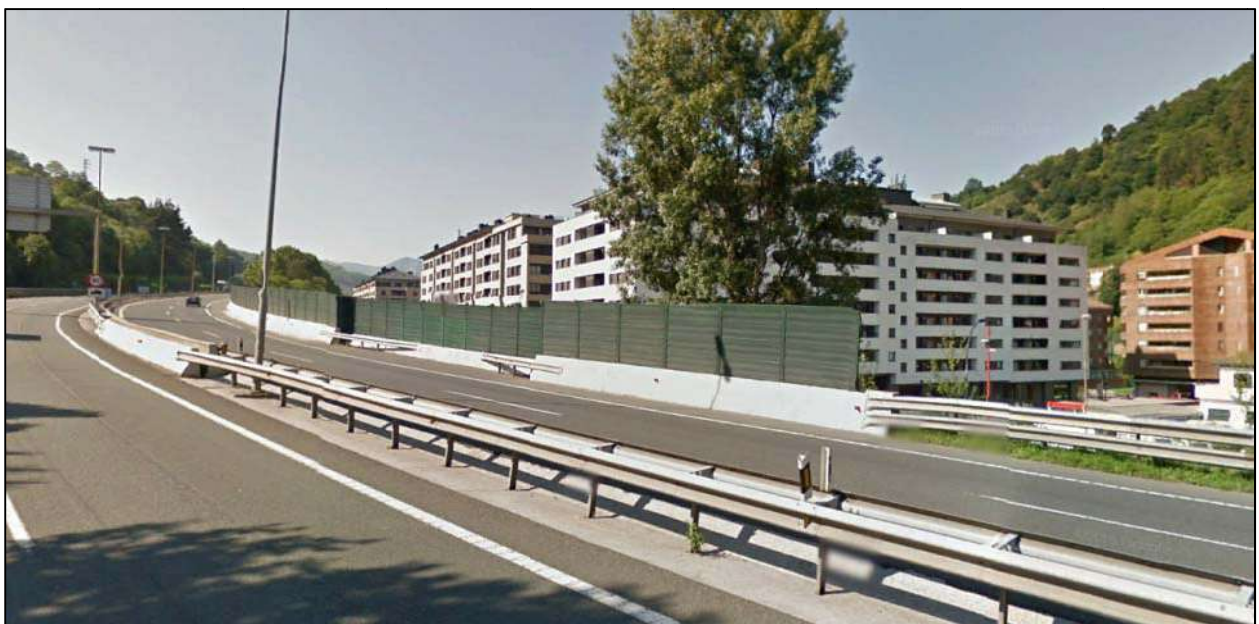
Edificaciones próximas a la A-I en Uzturri Kalea
